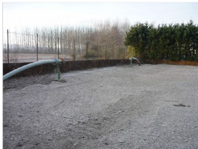
Figure 3 : Vues du site de l'ancienne station de pompage d'Urt après démantèlement
