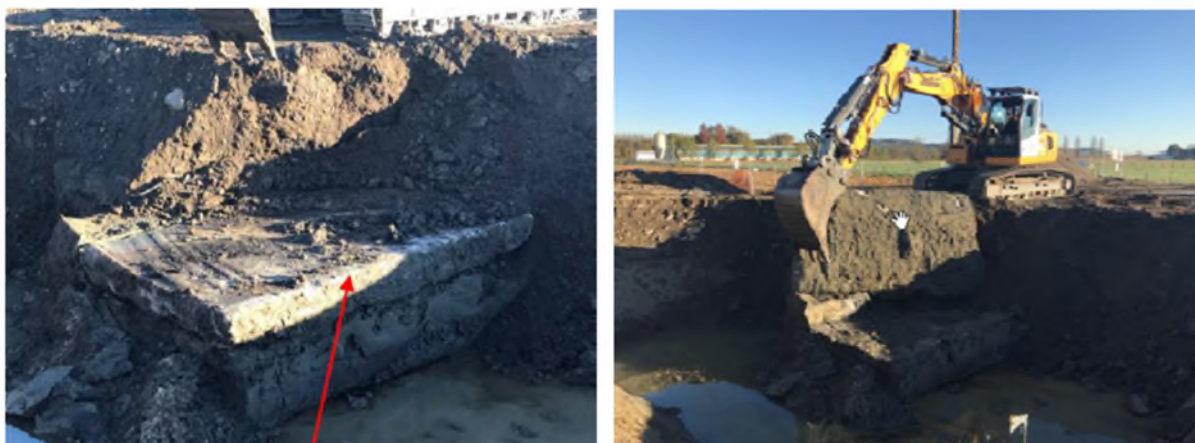
Figure 5 : Terrassement et dalle radier de la cuve de purge
