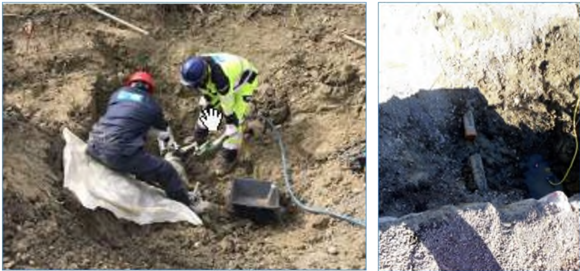
Figure 6 : Découpe et obturation de la canalisation
